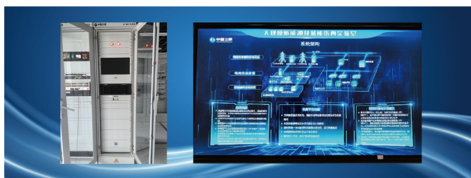
三峡乌兰布试验基地大规模新能源仿真
